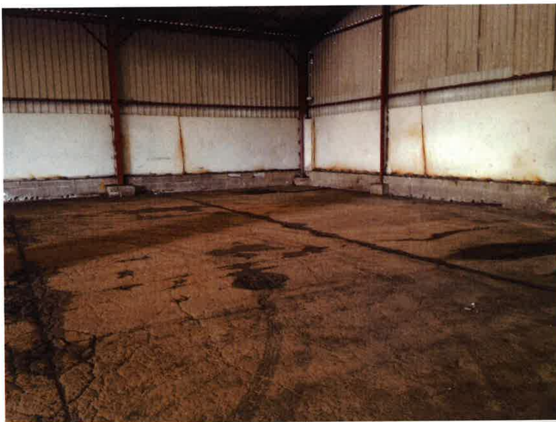
Photographie n° 3 : Vue du hangar de stockage en direction du Nord
