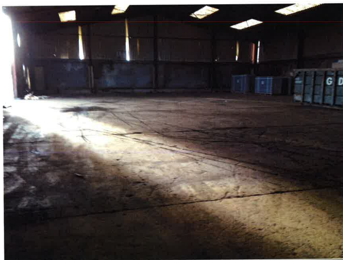
Photographie n° 4 : Vue du hangar de stockage en direction du Sud)
