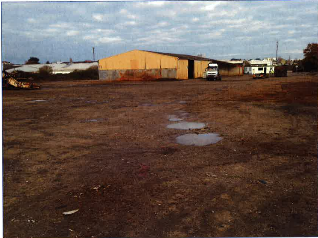
Photographie n° 1 : Vue de la dalle béton en direction du Nord
