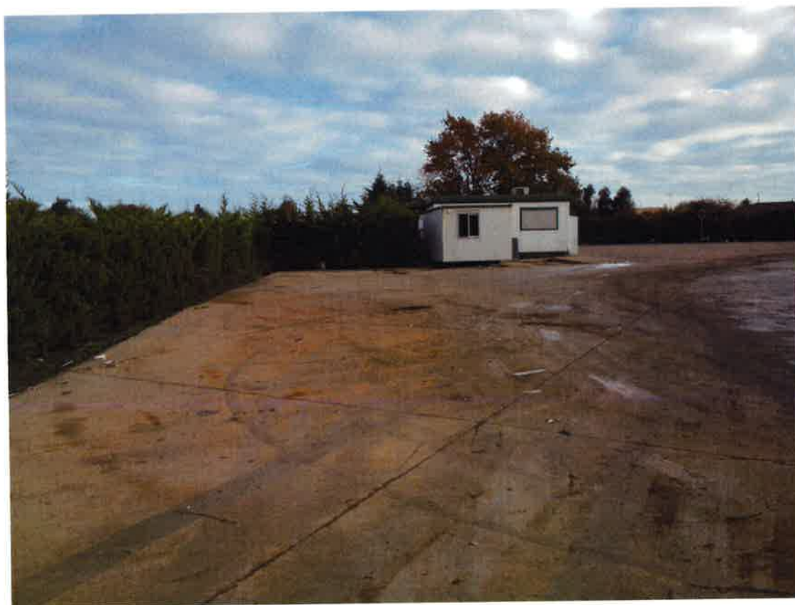
Photographie n° 6 : Vue de la partie Nord du site en direction de l'Est
